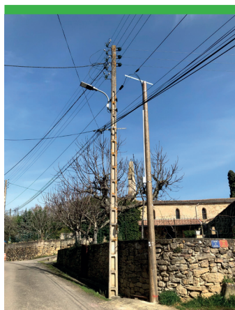
Déploiement de la fibre optique sur des supports électriques Enedis
