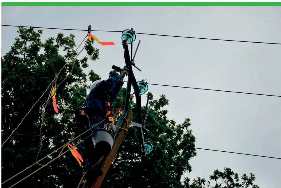
Pose de protection Avifaune sur support HTA
