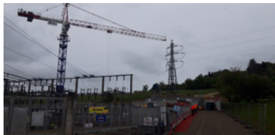
Agrandissement du Poste Source de Vic-Fezensac.
